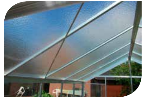
6. Schroef alle bouten en trekklatten aan
