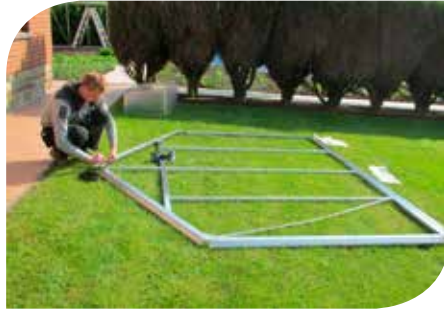
2. Monteer zijgevels en kopgevels
